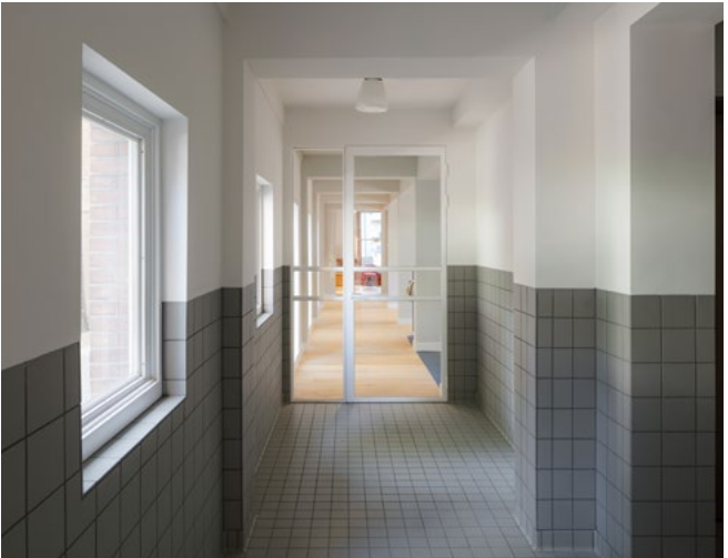
Leistenen vloertegels van de kerkzaal hergebruikt.
