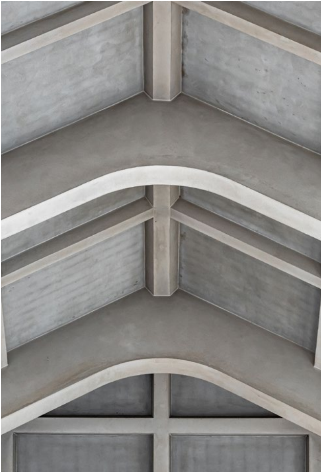
We hebben fijn zand aangebracht dat past bij het oorspronkelijke cement in het dak.
