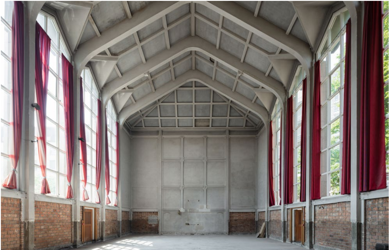
De grafische kracht van de oorspronkelijke betonstructuur.
