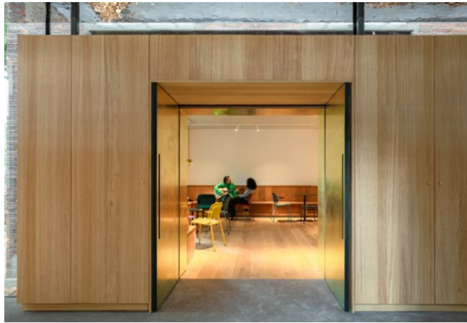
De draagstructuur verborgen in houten kasten.
