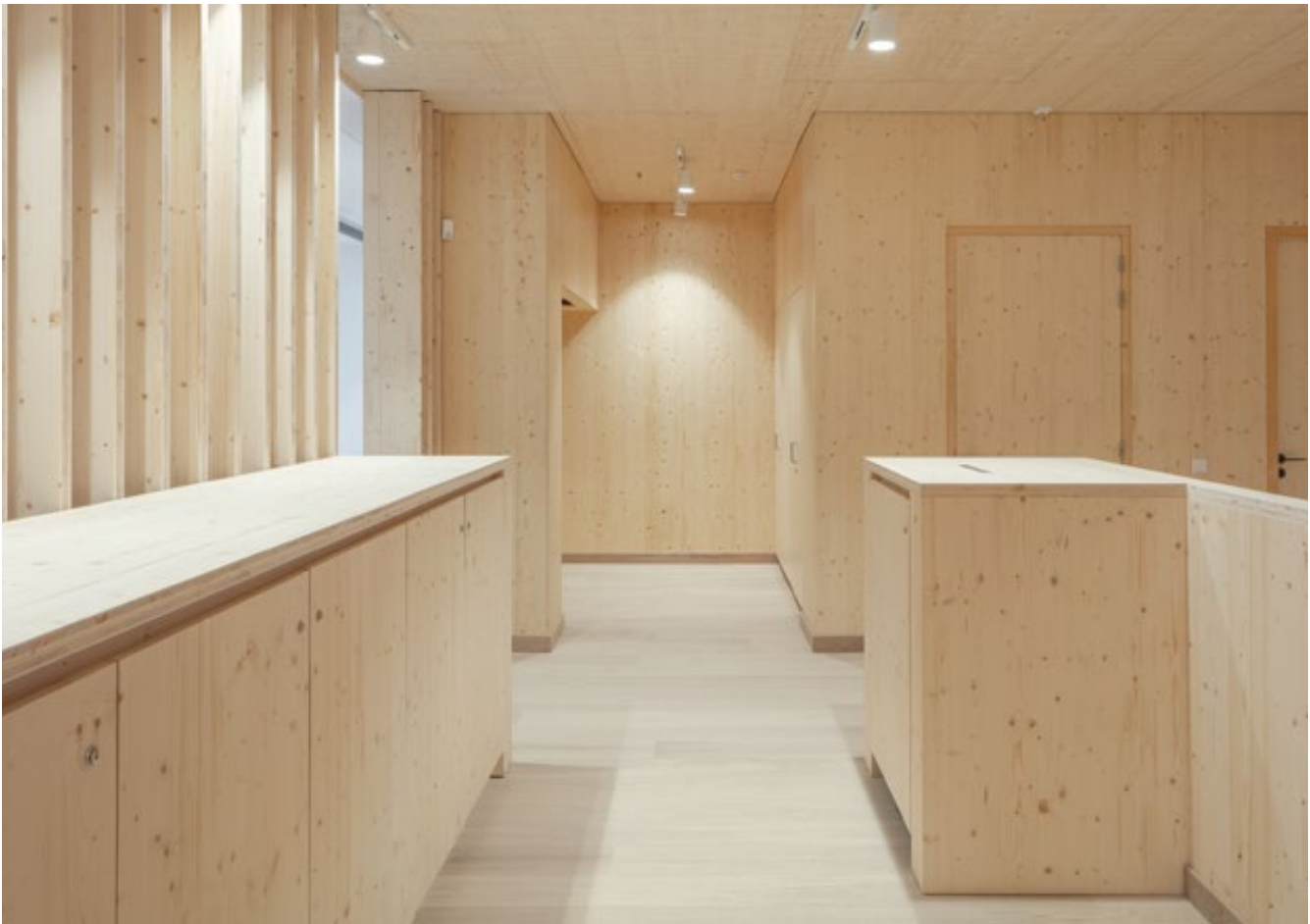
Het akoestische houten lattenplafond tussen de balken verbergt de techniek subtiel
