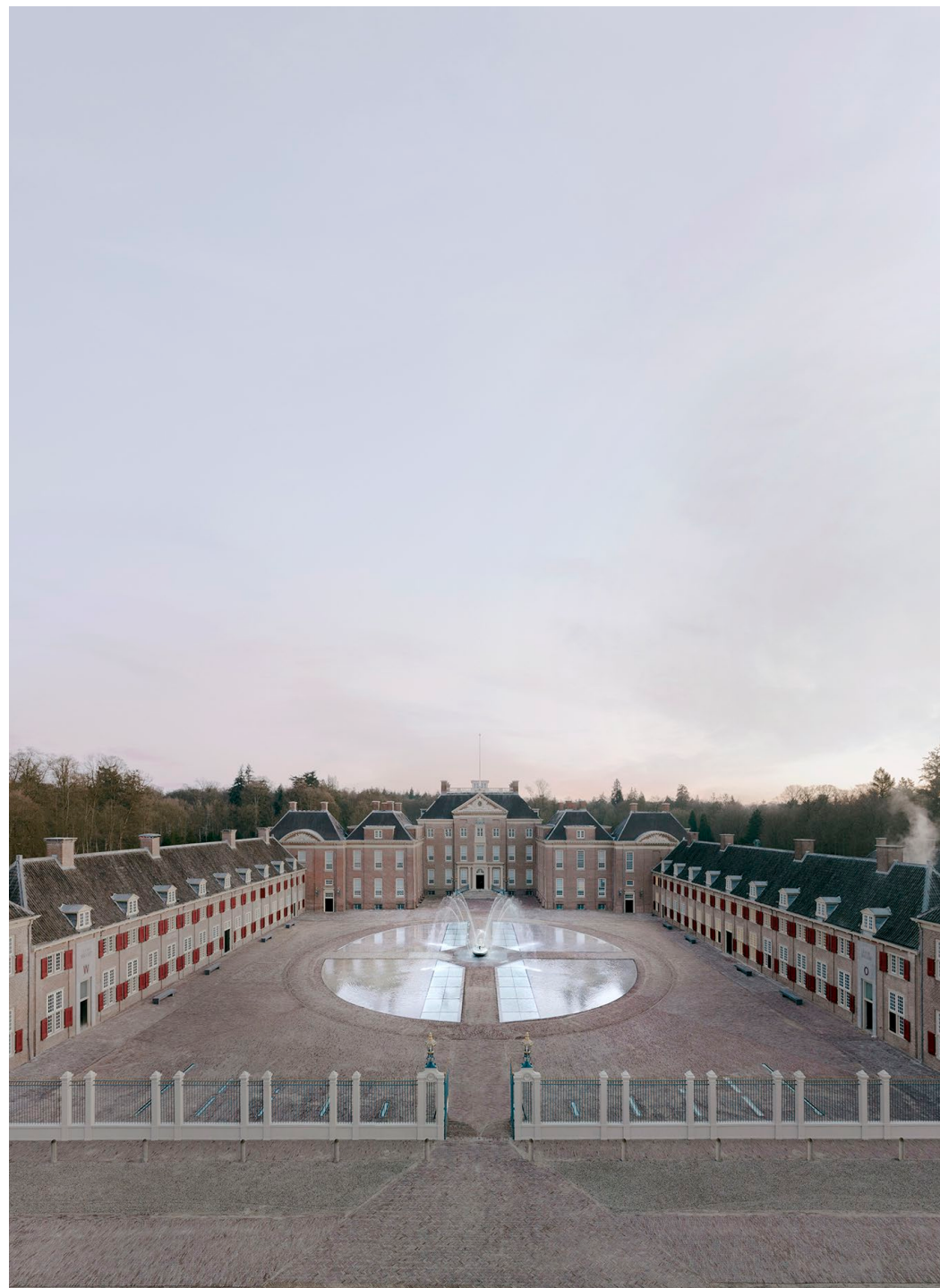
De gehele uitbreiding is ondergronds gerealiseerd en de nieuwe waterpartij is met de architectuur geïntegreerd, waardoor de traditie van een totale compositie zich voortzet zonder het historische beeld te verstoren.
